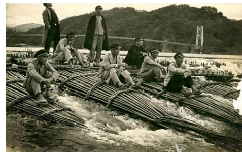
▲二水跑水節將八堡圳通圳秘法籠仔篙重現。(圖/二水鄉公所提供)
